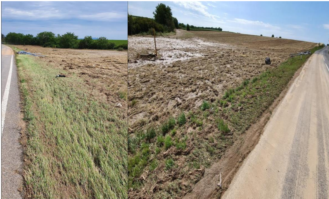
1410/1 k.ú. Žlkovce (875007), obec Žlkovce- vyšších 6 ks foto
